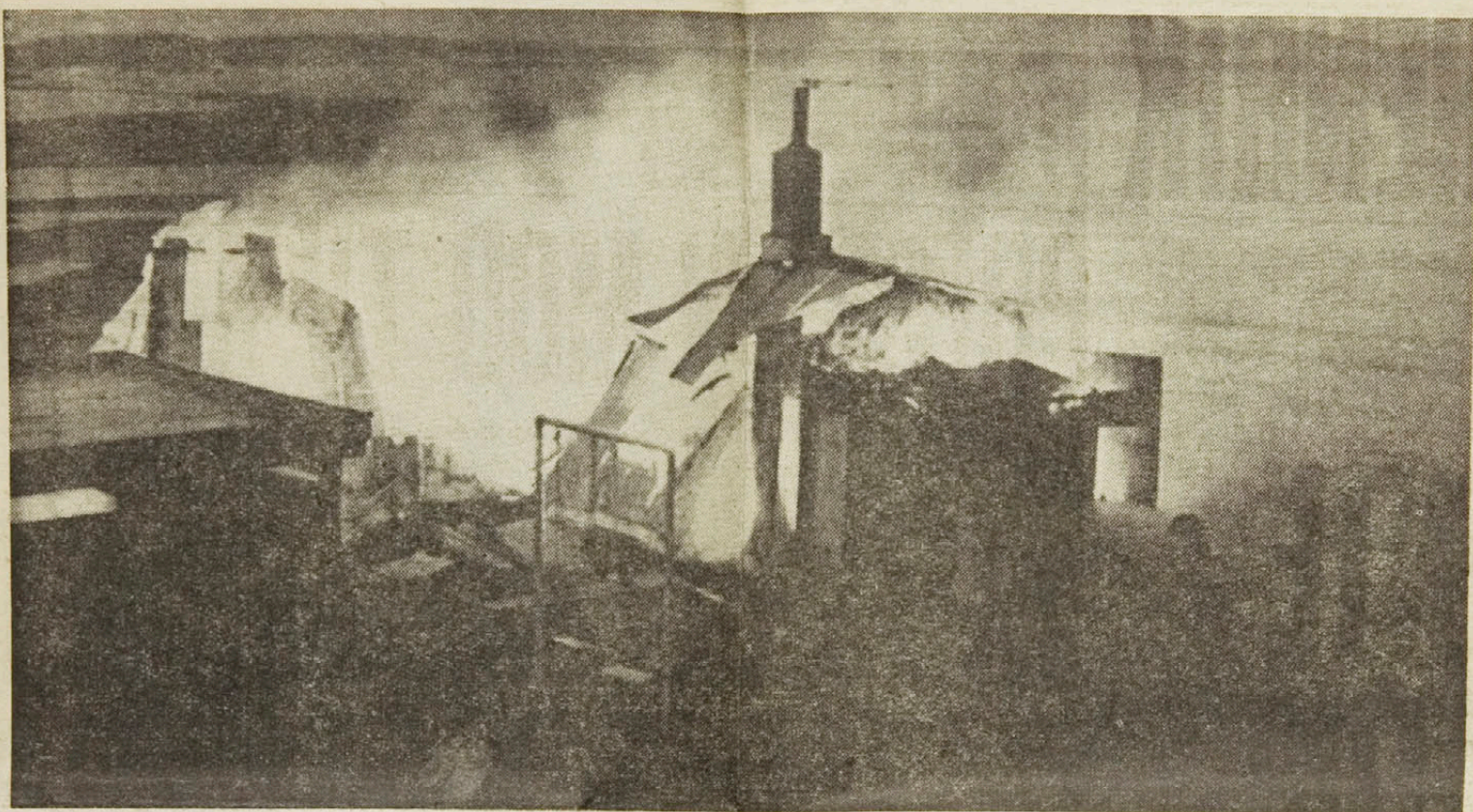
Taget er skredet sammen over det flammende sommerhus, hvor Islands statsminister, hans hustru og datteren omkom.
