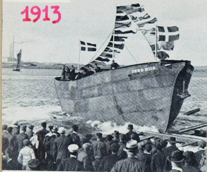
Værftets første nybygning »Jens Riis« ved søsætningen og på prøveturen i 1913
