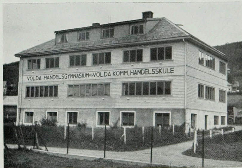
Volda Handelsgymnas og Handelsskule.
