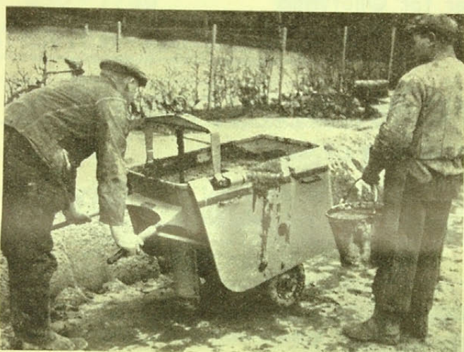
MUD-JACKEN I ARBEJDE
